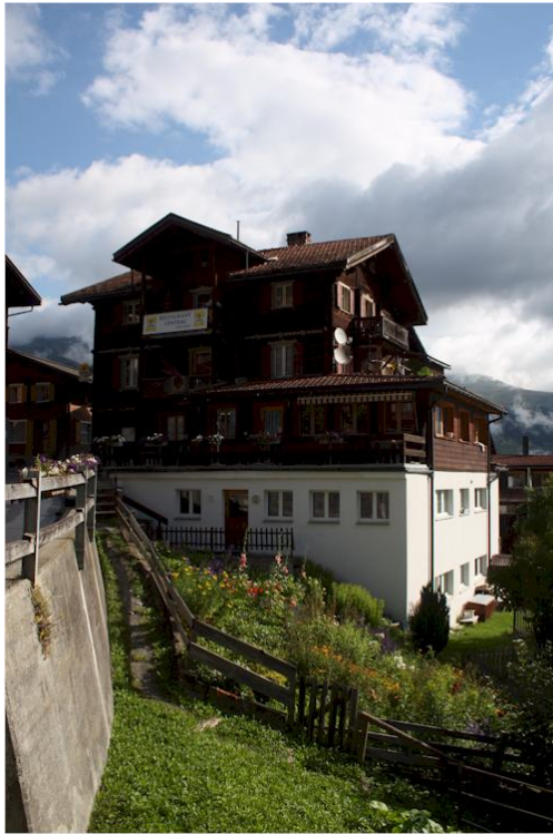
Fassade Südwest- Ost
